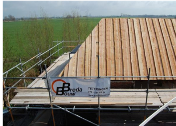
Het vernieuwde dakbeschoot
