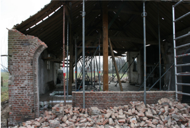
De voormalige noordgevel
