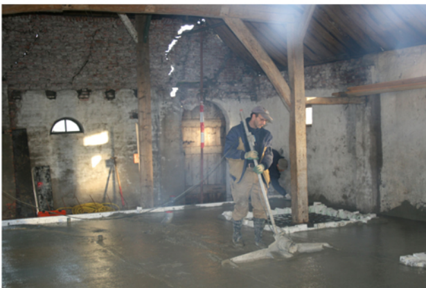
Het storten van de vloer (in fases)
